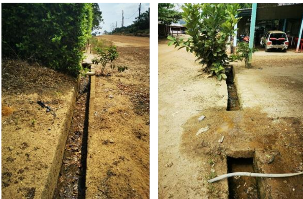
Fotografía 3. Canales perimetrales sobre las vías para el transporte de aguas residuales y aguas lluvias
