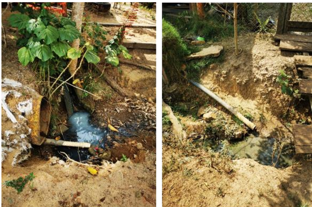
Fotografía 1. Vertimientos aguas residuales de las viviendas hacia las vías existentes
